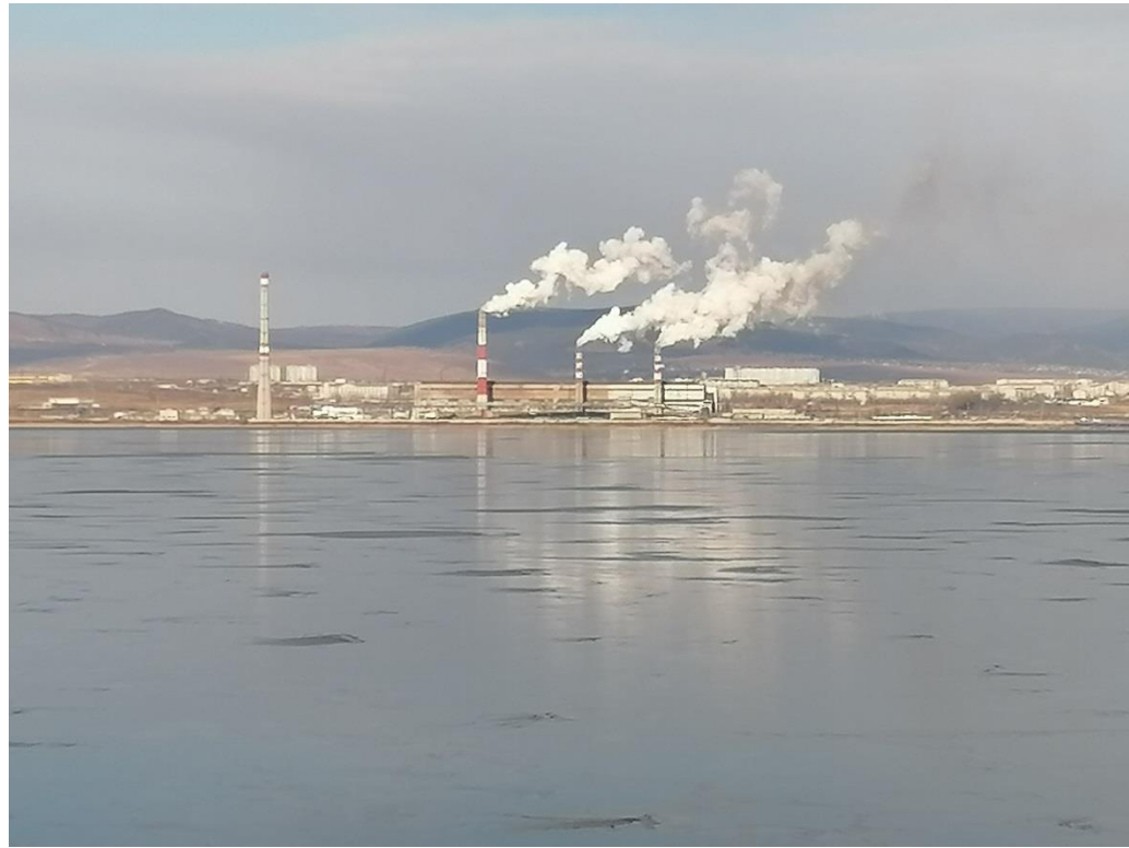
Рис. 1. Фотография теплоэлектростанции на берегу оз. Кенон. 07 ноября 2021 год.
